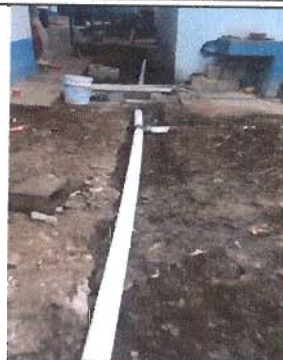
zanjear y colocación de tubo de drenaje
