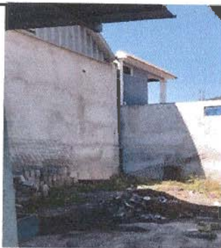
preparación de terreno para fundición de piso
