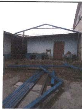
elaboración de estructura para techo
